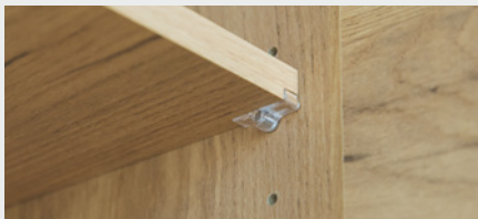
Półki w szafkach wiszących zabezpieczone przed wysunięciem.
